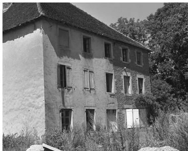
L'habitation : façade sur cour. Phot. Yves Sancey IVR43_19803900117X
