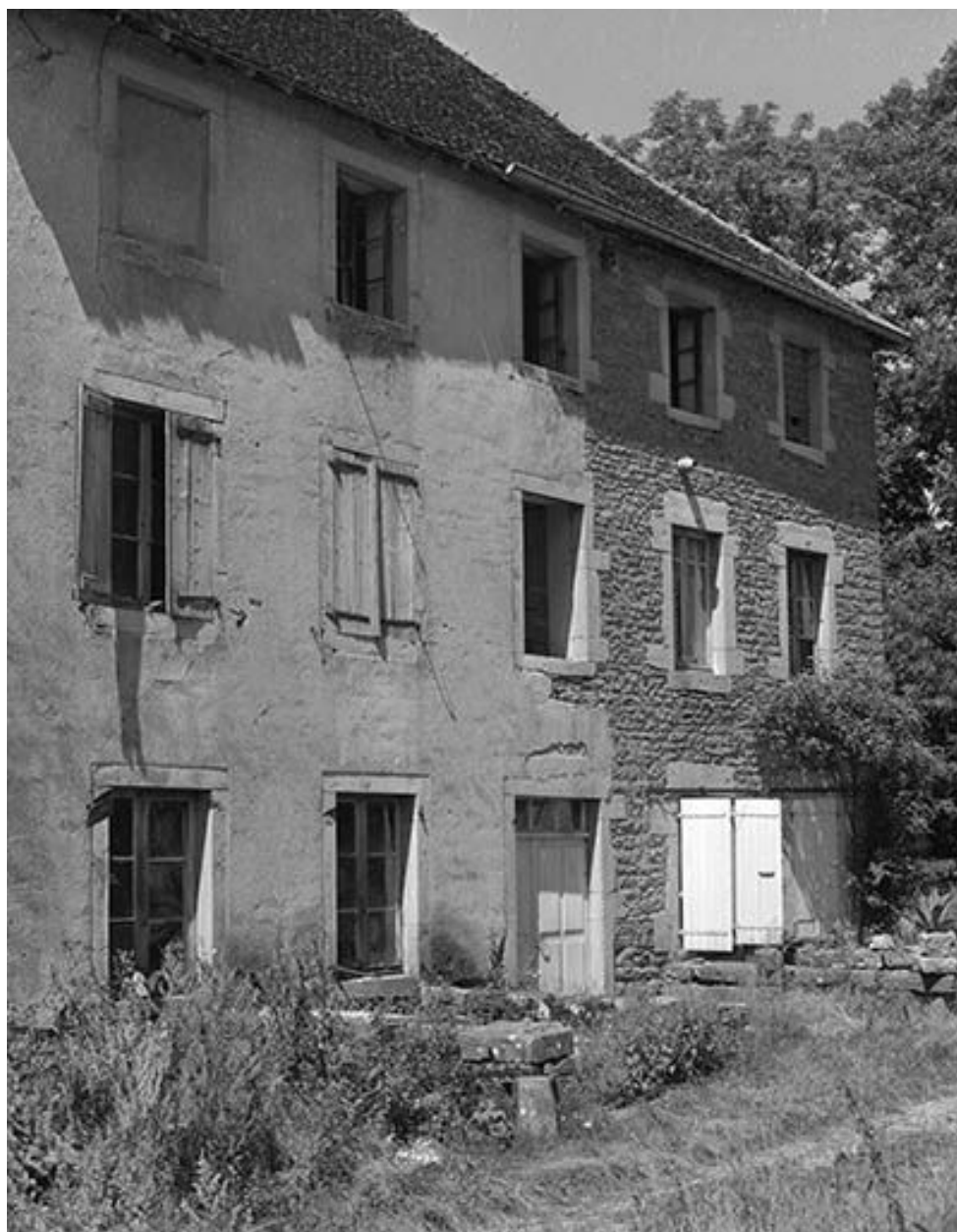
L'habitation : façade sur cour, détail.
