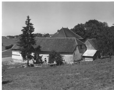
Vue générale depuis le sud. Phot. Yves Sancey IVR43_19803900115X
