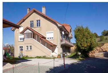
Vue d'ensemble depuis la rue de l'Industrie.
