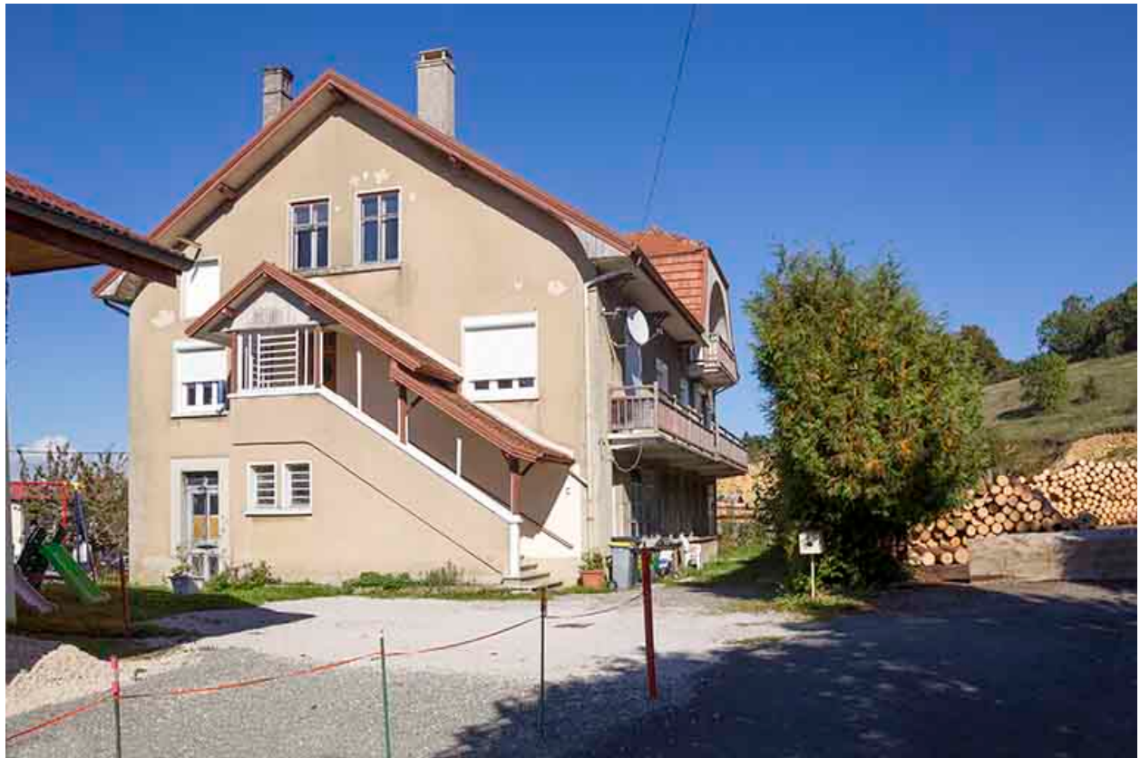
Vue d'ensemble depuis la rue de l'Industrie.
