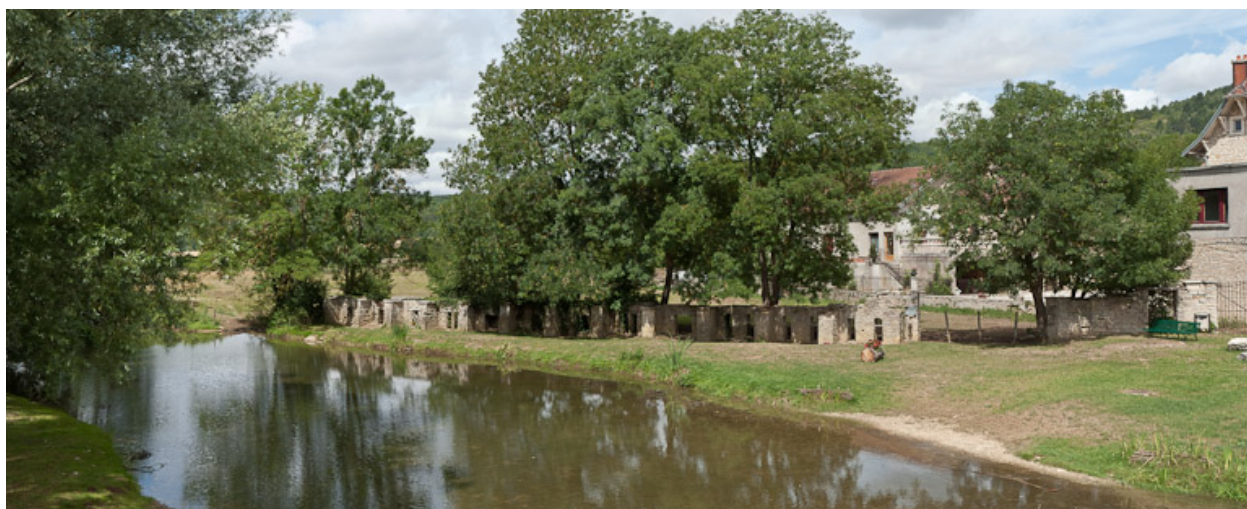
Vue du mur dit "évacuateur de crue".
