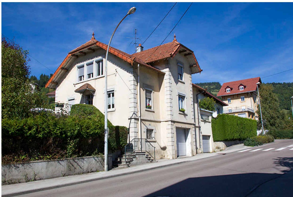
Façades antérieure et latérale gauche.
