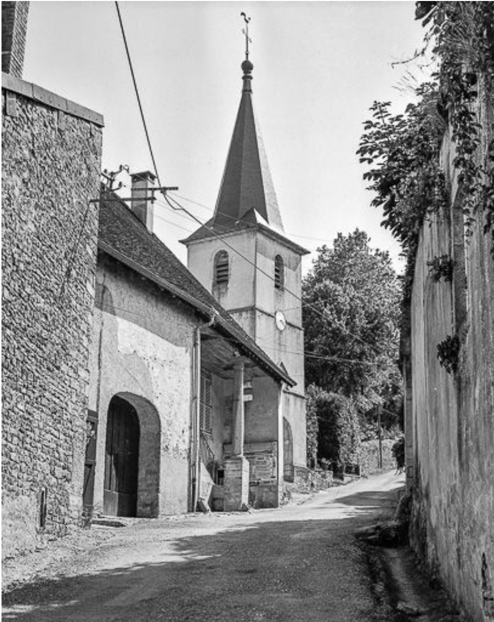
Maison de vigneron située rue de l'Eglise.
