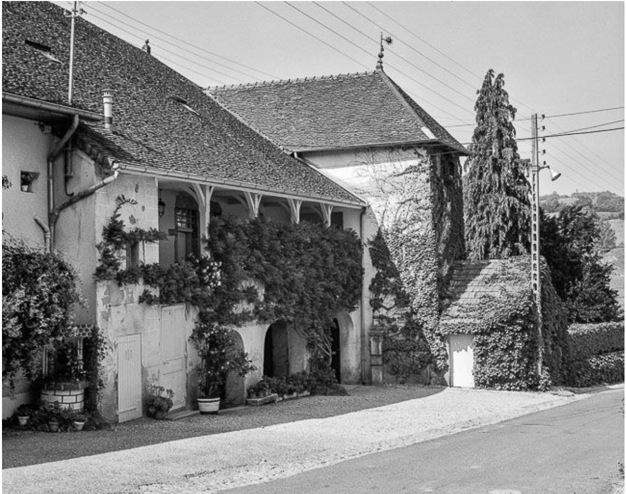
Maison de vigneron située rue de l'Eglise.
