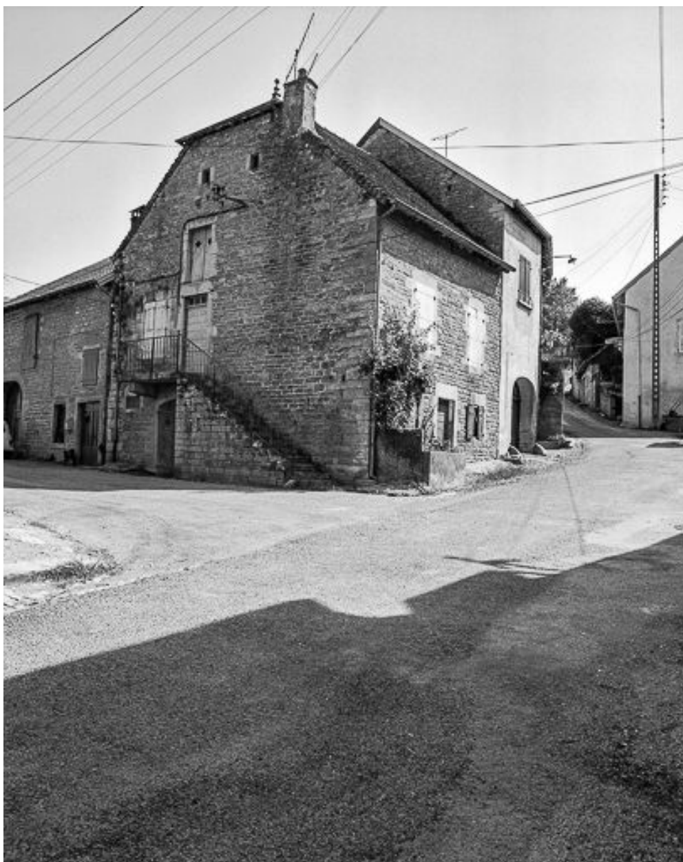
Maison de vigneron située rue de l'Eglise.
