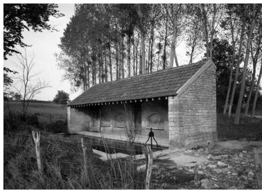
Vue côté bassin. Phot. Michel Rosso IVR26_19852101123V
