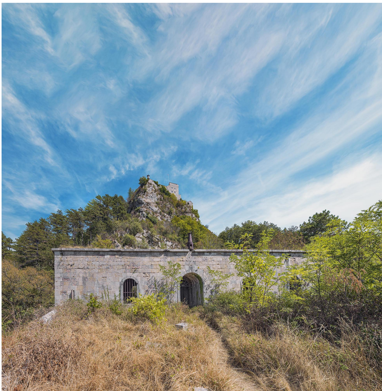
Le bâtiment casematé : la façade antérieure.
