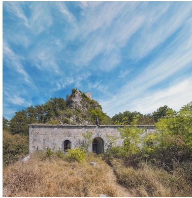
Le bâtiment casematé : la façade antérieure. Phot. Thierry Kuntz IVR43_20223901144NUC4A
