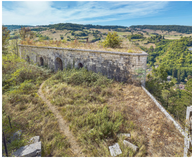
Le bâtiment casematé : façade postérieure. Phot. Thierry Kuntz IVR43_20223901139NUC4A
