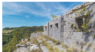
Détail des embrasures au-dessus de la porte. Phot. Thierry Kuntz IVR43_20223901141NUC4A
