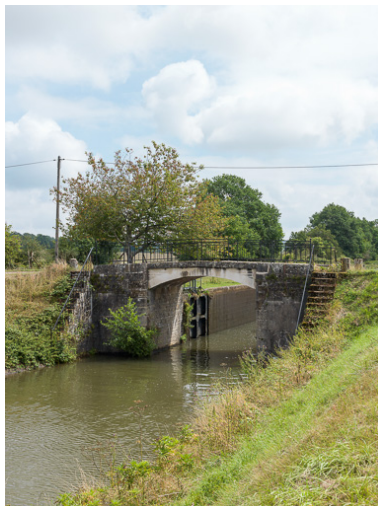
Vue du pont. Phot. Pierre-Marie Barbe-Richaud IVR26_20175800290NUC2A
