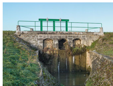
Vue du déversoir. Phot. Pierre-Marie Barbe-Richaud IVR26_20132101046NUC4AQ
