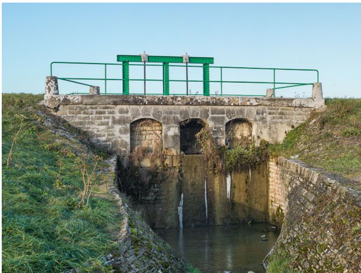
Vue du déversoir.
