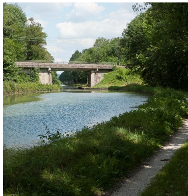
Vue du pont.
