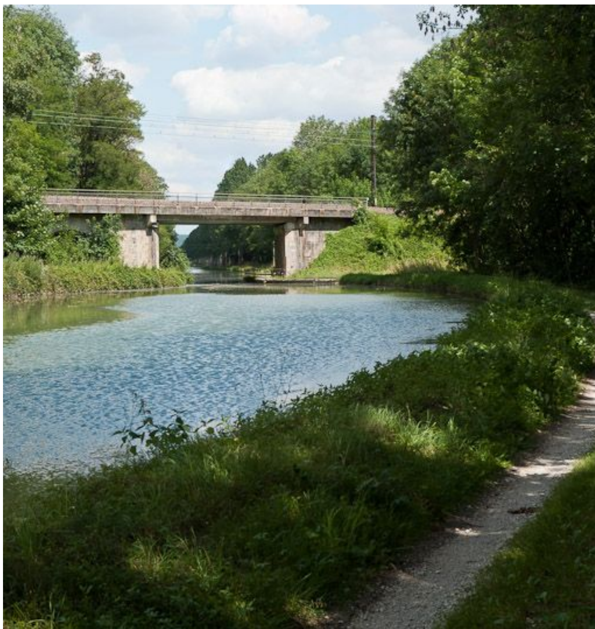
Vue du pont.
