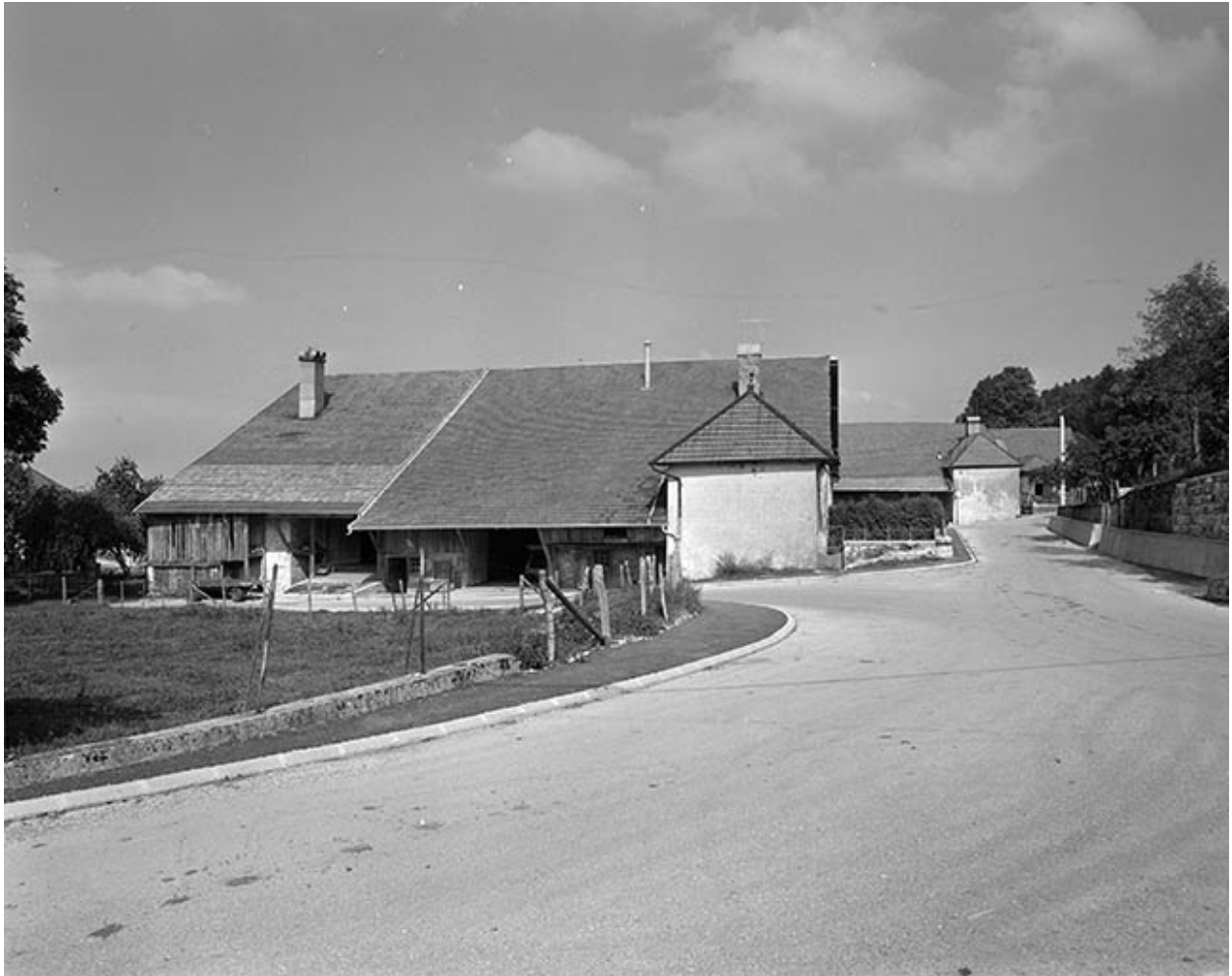
Vue d'ensemble des fermes.
