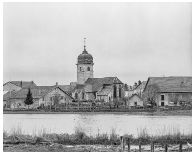
Vue de situation. Phot. Yves Sancey IVR43_19812500097X
