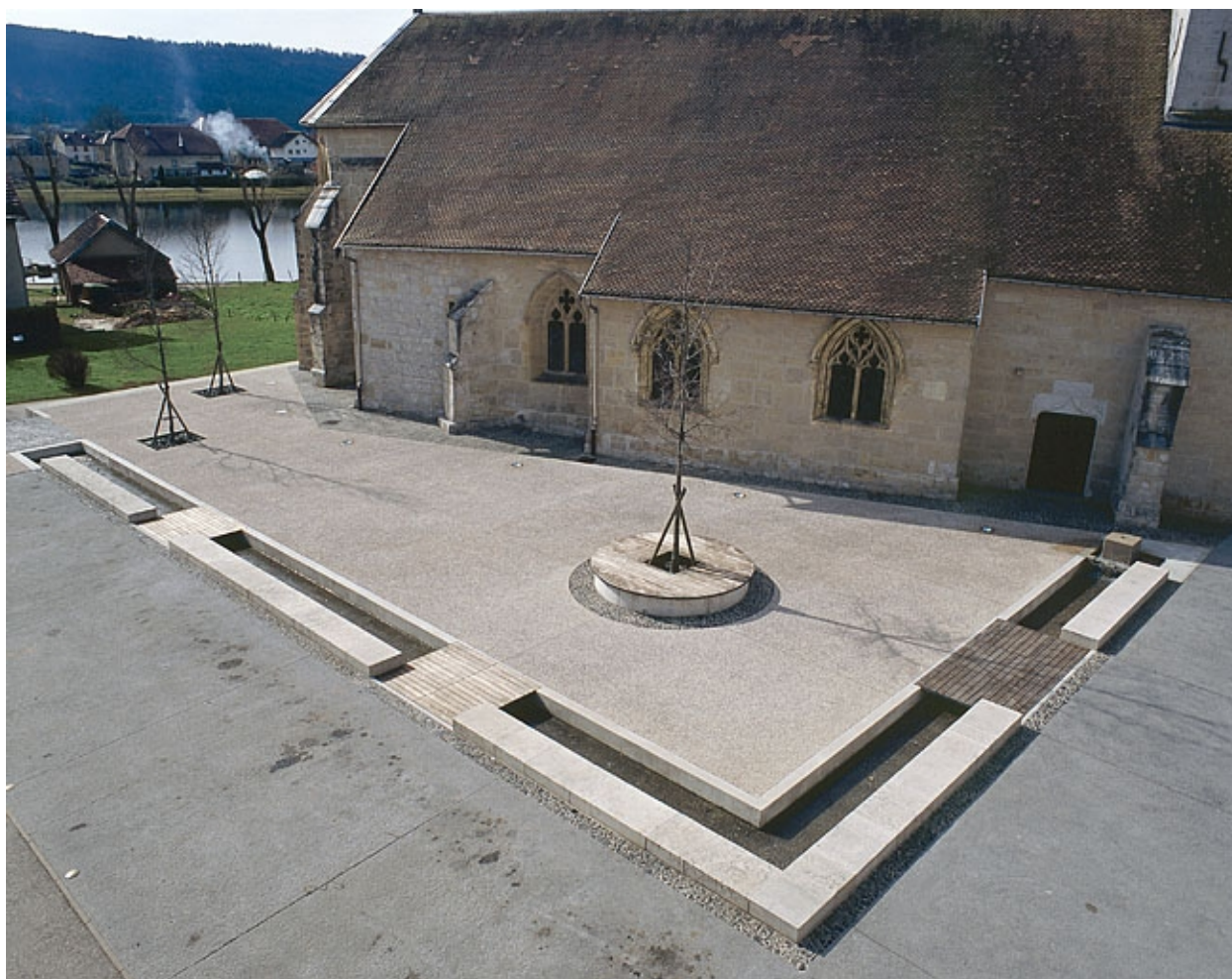
Façade latérale gauche donnant sur la place Charles le Téméraire.
