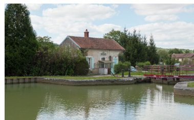
Vue du site d'écluse depuis l'amont. Phot. Pierre-Marie Barbe-Richaud IVR26_20112104011NUC4AQ
