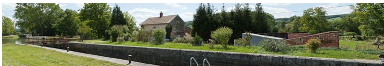
Vue d'ensemble du site d'écluse.
