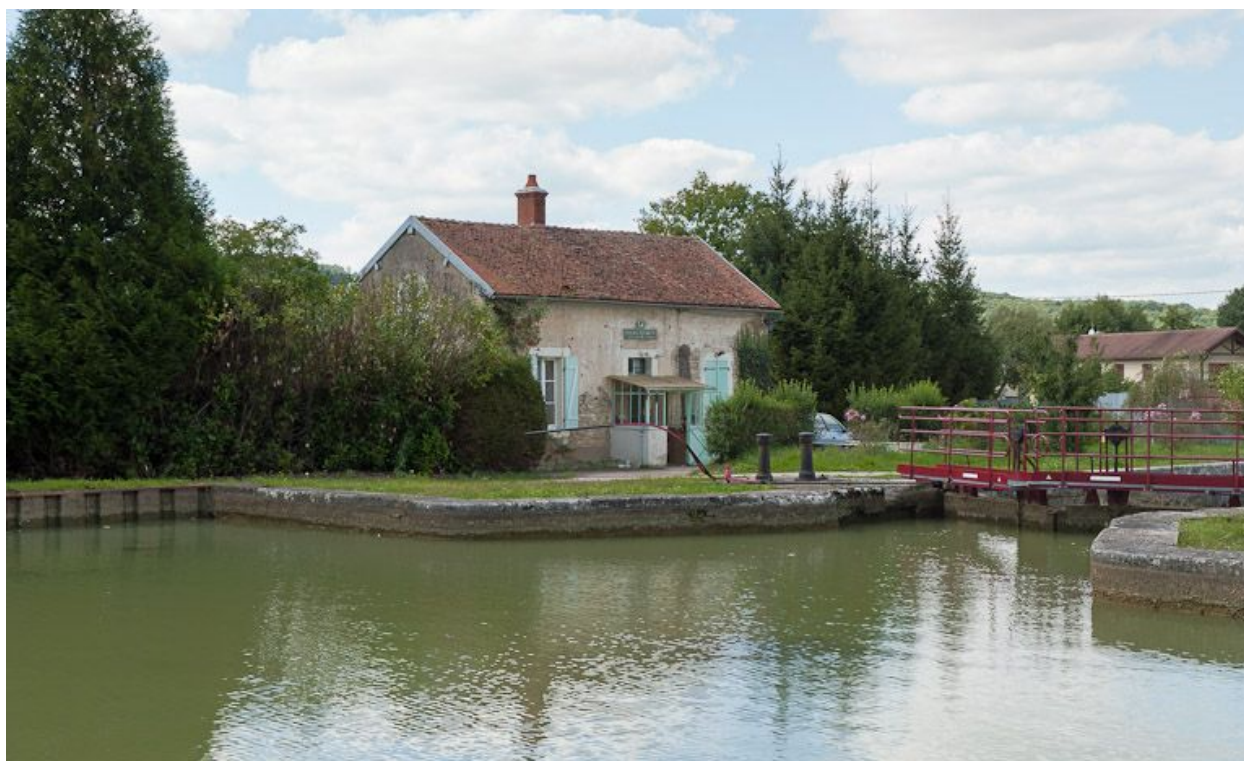
Vue du site d'écluse depuis l'amont.
