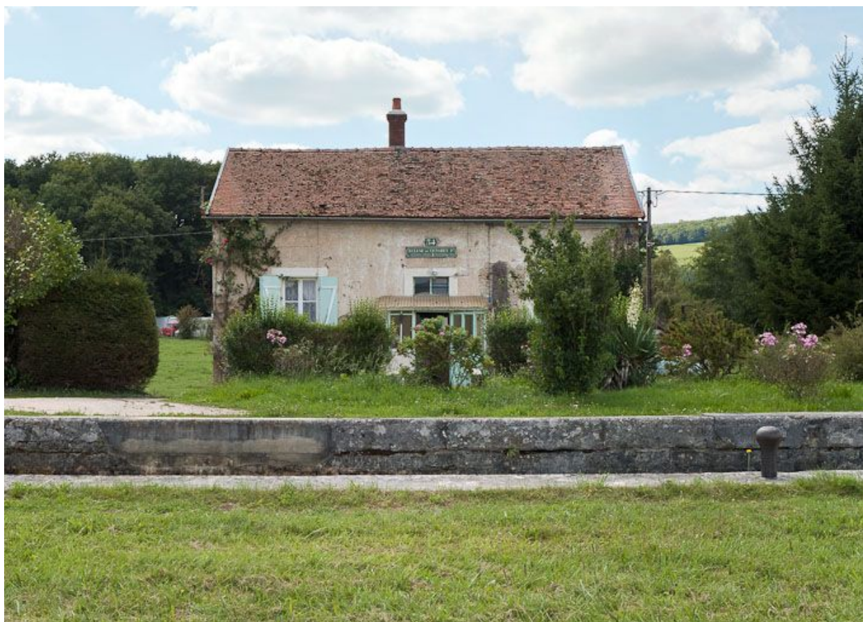
Vue de face de la maison éclusière.
