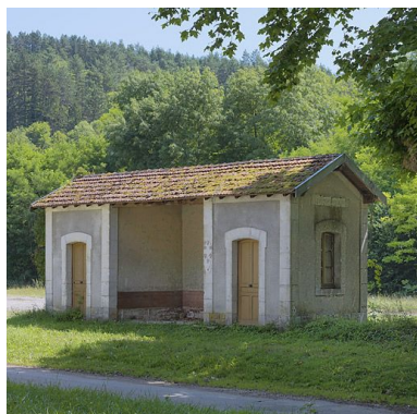
La lampisterie. Phot. Thierry Kuntz IVR26_20122102556NUC4A
