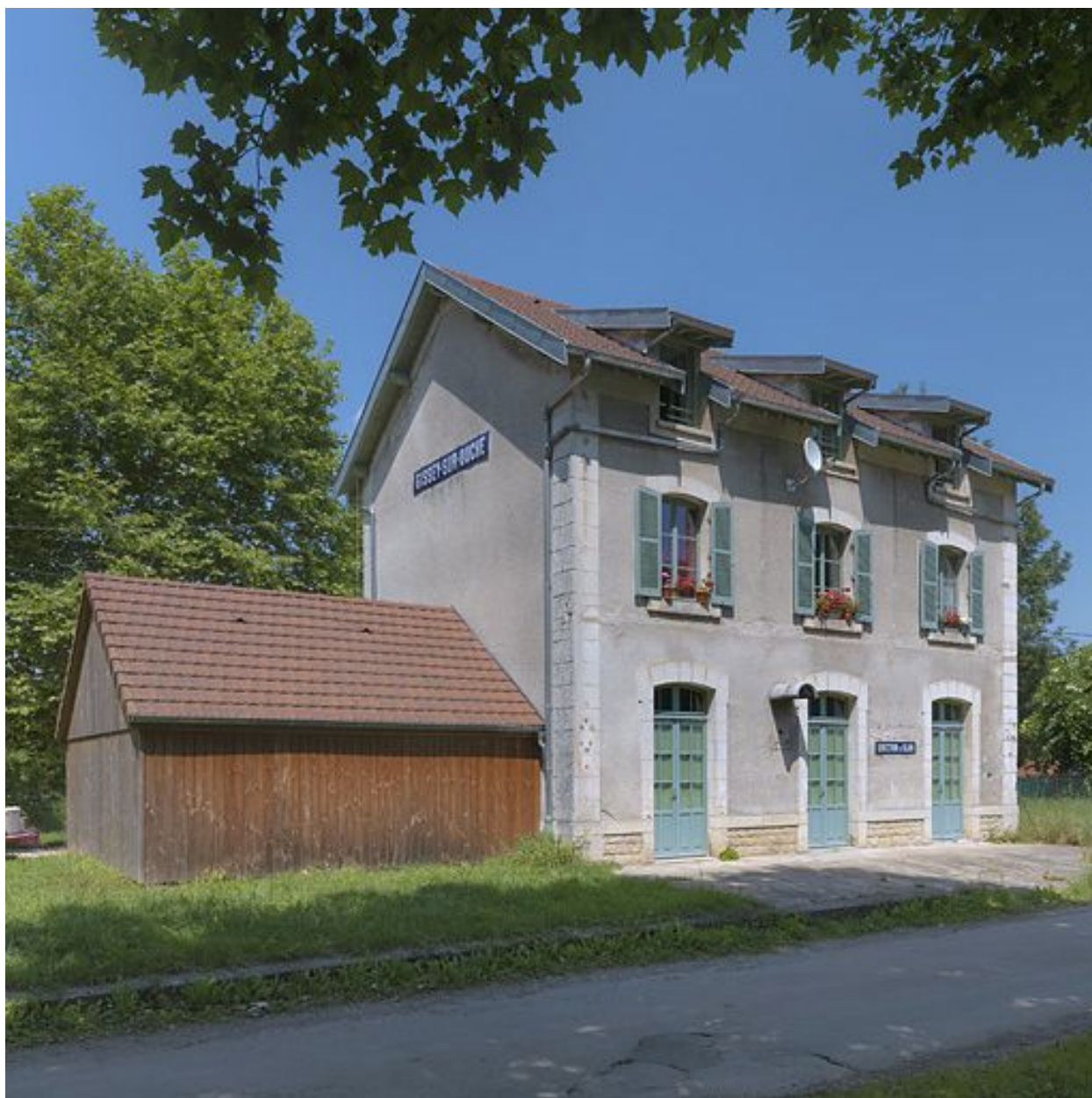
Le bâtiment des voyageurs, 3/4 gauche.
