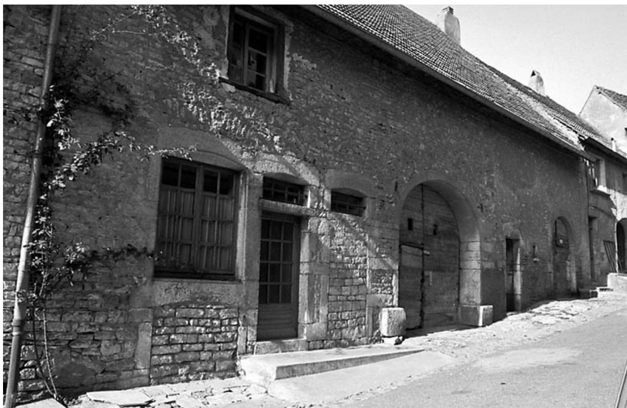
Façade antérieure vue de trois quarts gauche.
