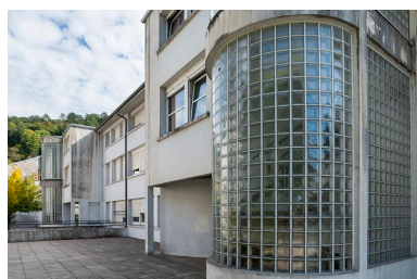
Façade postérieure. Phot. Jérôme Mongreville IVR43_20172501129NUC4A
