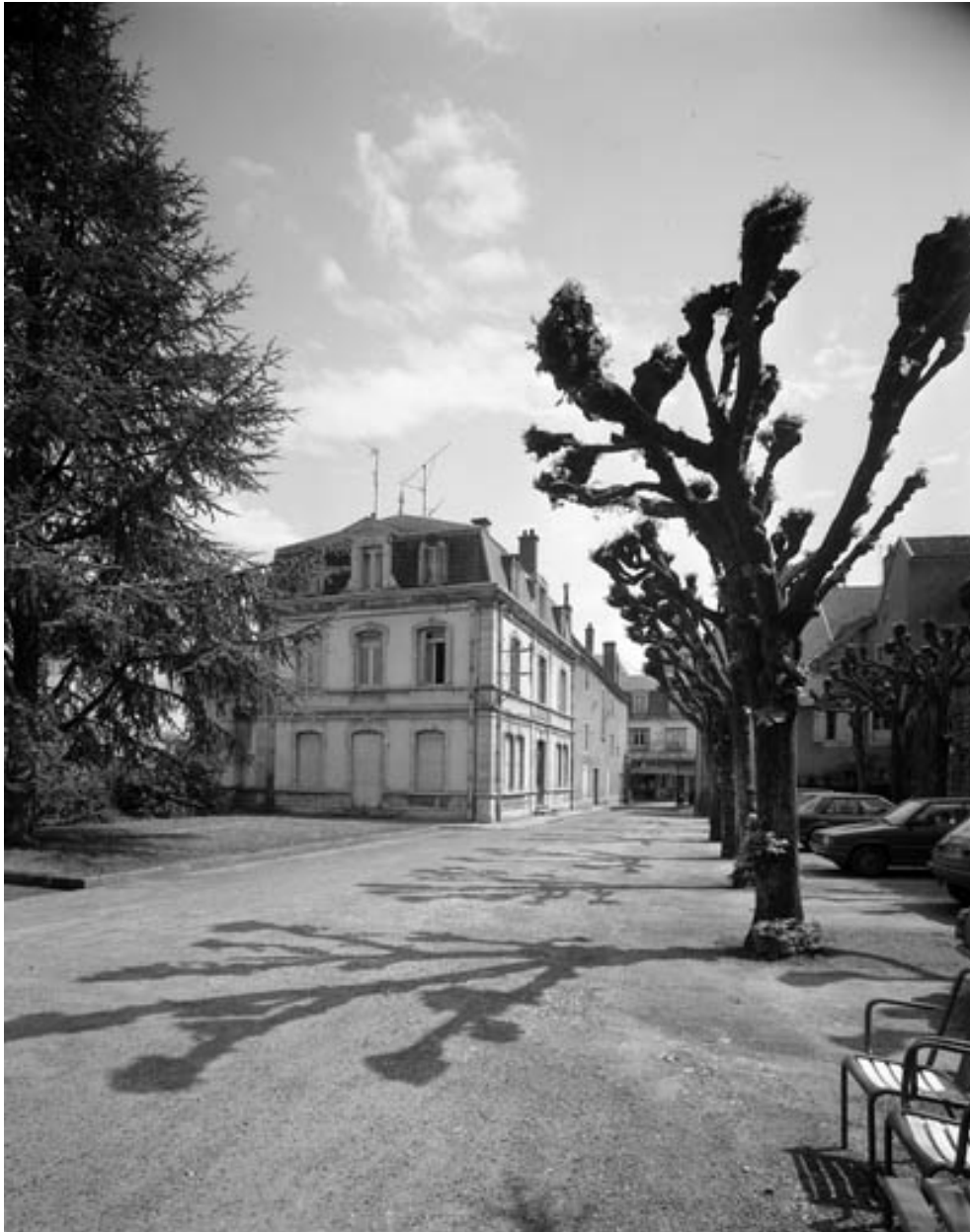
Bâtiment administratif : vue d'ensemble.
