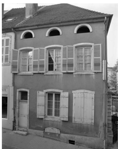
Logement de l'aumônier : façade antérieure de face.
