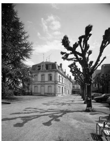
Bâtiment administratif : vue d'ensemble.
