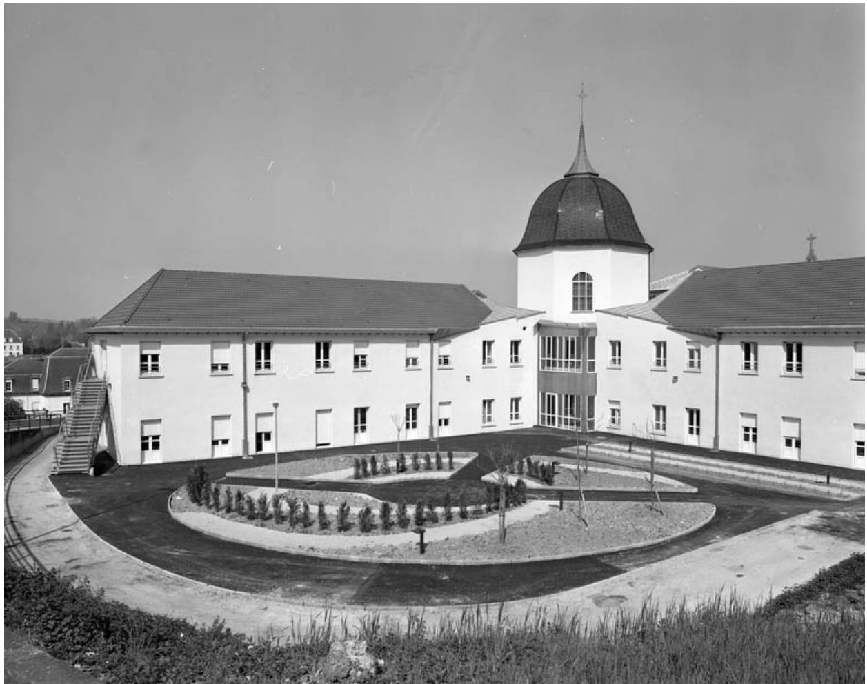
Cour à l'arrière de l'édifice : vue rapprochée.
