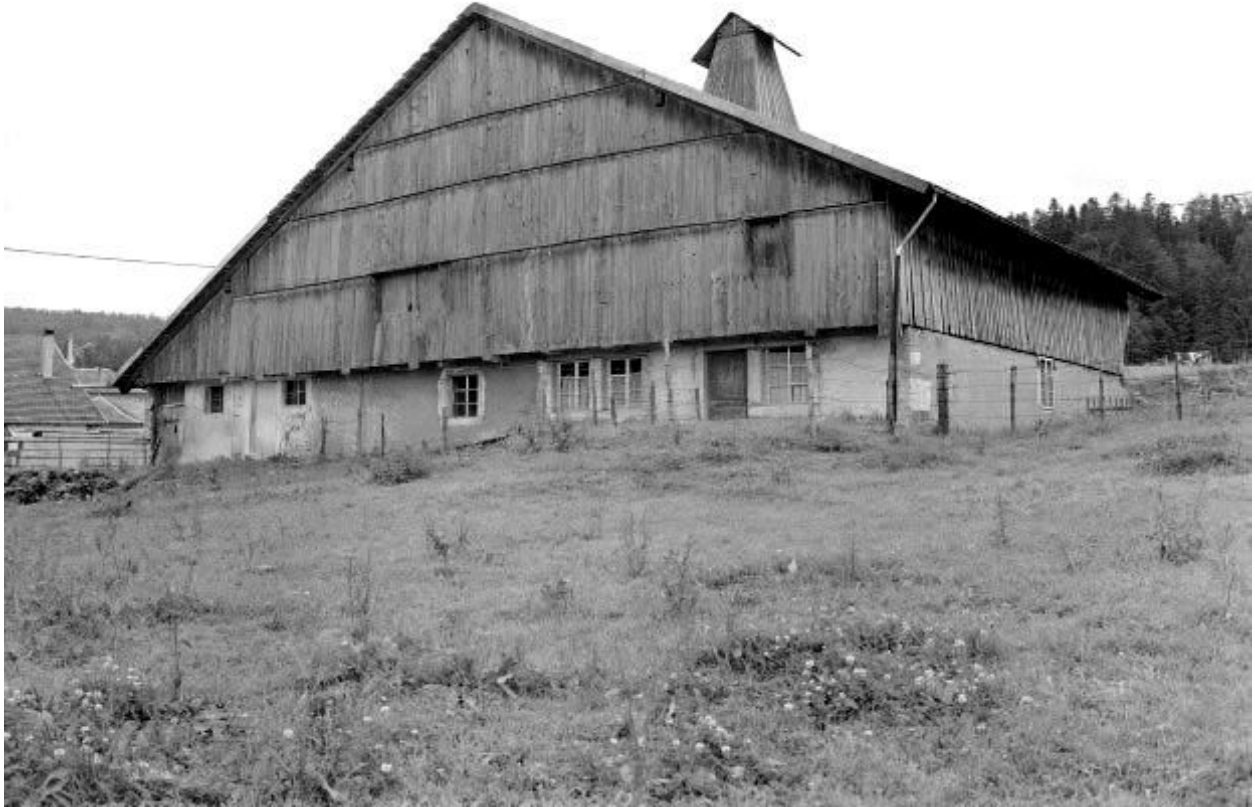
Façades postérieure et latérale gauche.
