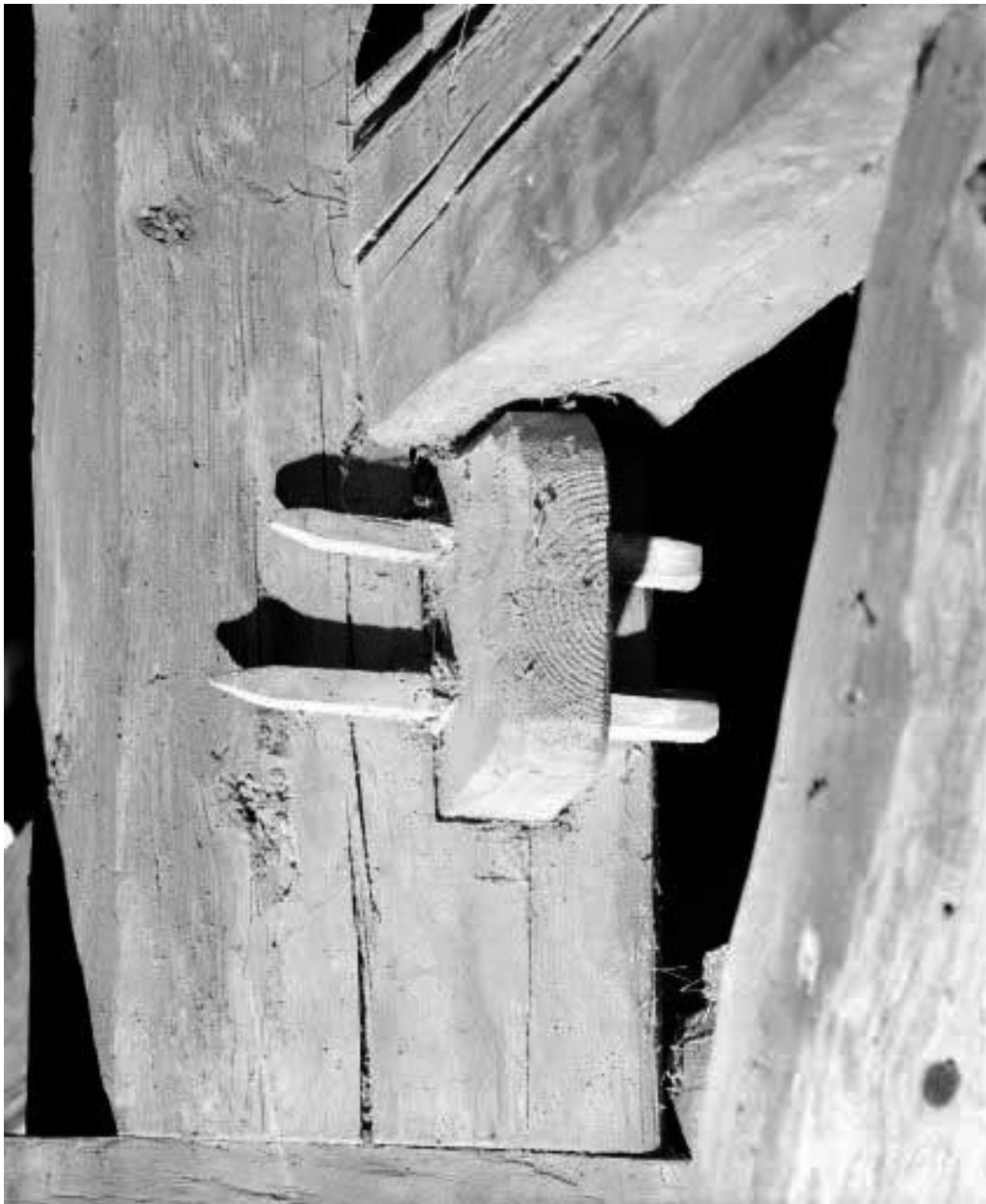
Détail : assemblage de charpente.
