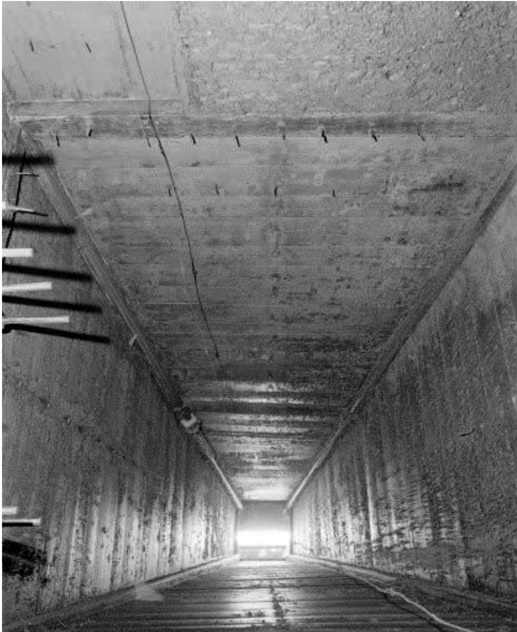
Intérieur : conduit du "tué".
