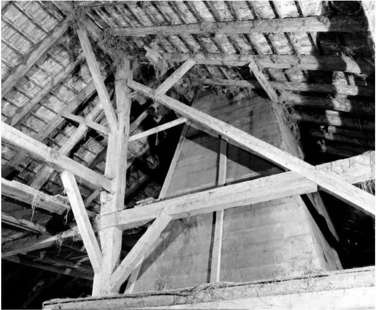
Intérieur : charpente et conduit du "tué".
