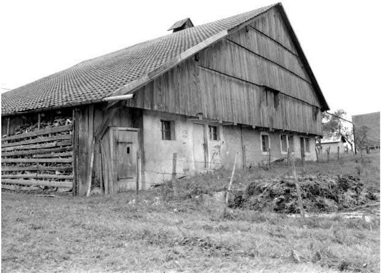
Façades postérieure et latérale droite.
