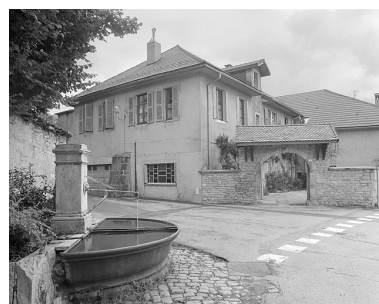
Le presbytère. Phot. Jérôme Mongreville IVR43_19963901155X
