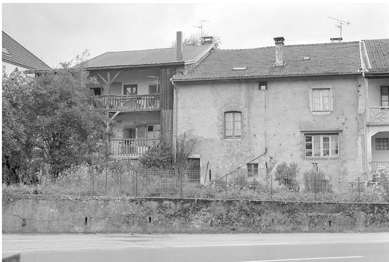
Grande Rue, façades postérieures d'anciennes fermes.
