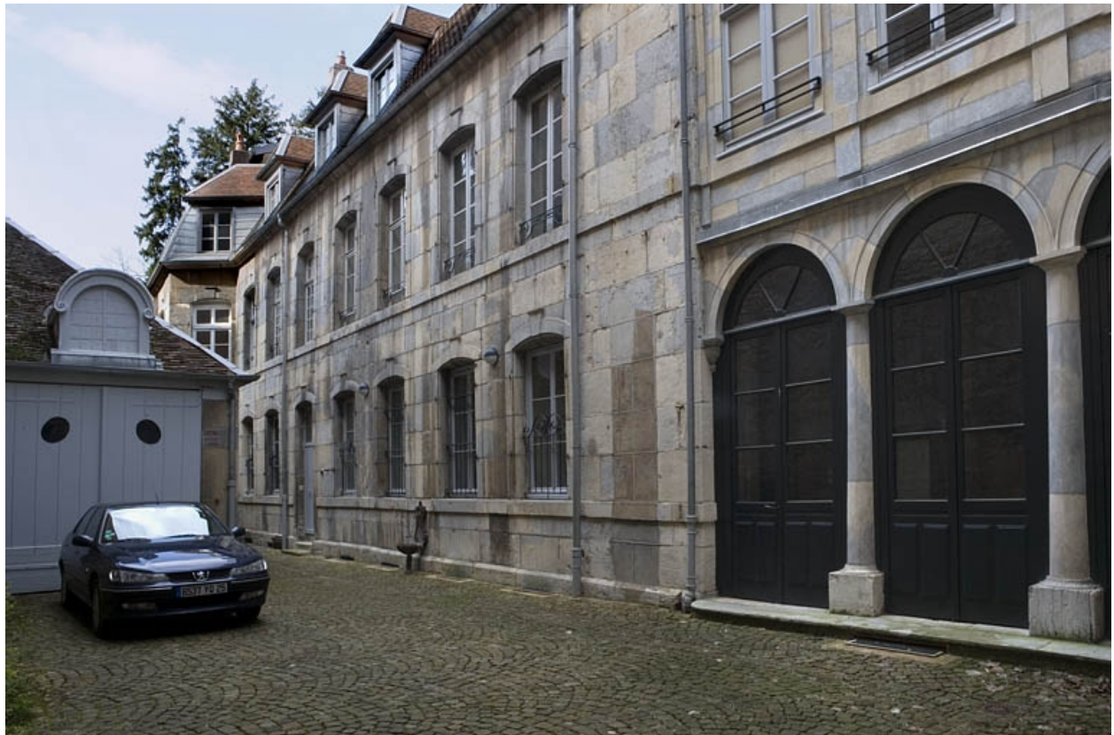
Vue d'ensemble de l' aile sur cour.
