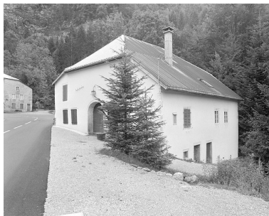
Façades nord-est et nord-ouest.
