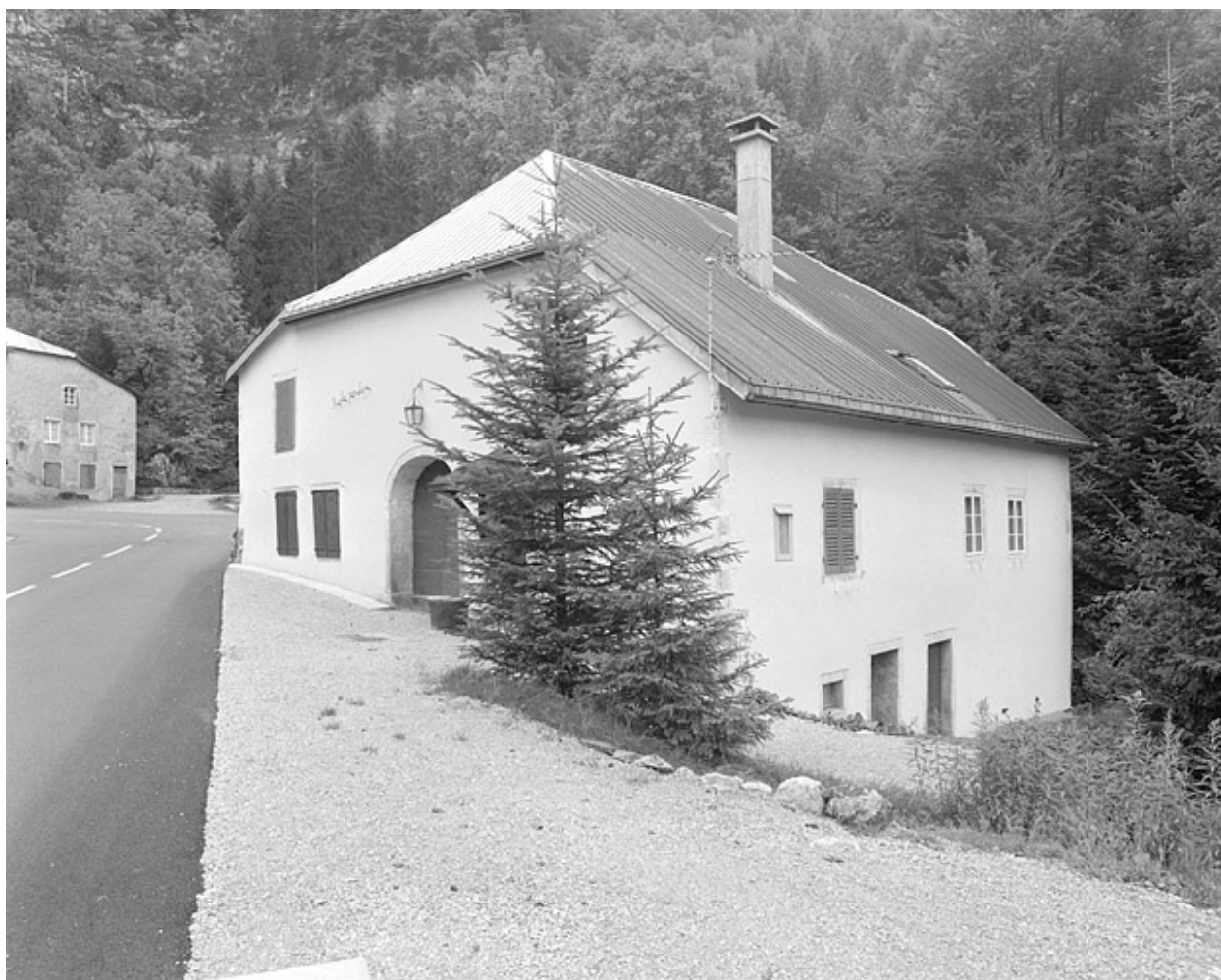
Façades nord-est et nord-ouest.
