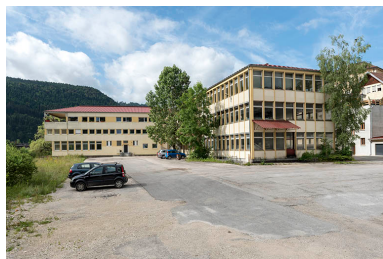
Site récent, vu du nord. Phot. Sonia Dourlot IVR43_20162500831NUC4A
