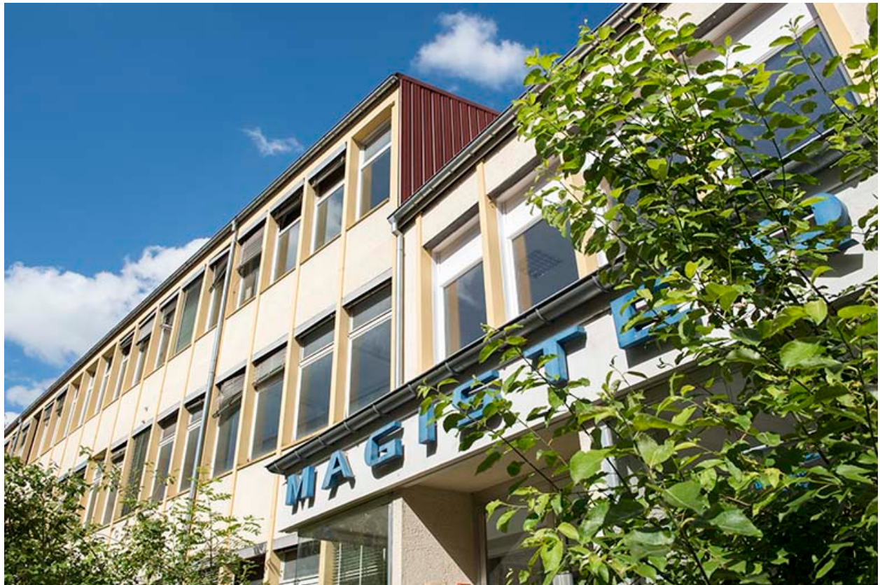
Site récent : entrée, vue en contre-plongée.
