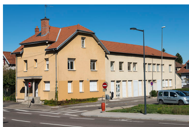
Vue de trois quarts, depuis le sud-ouest. Phot. Jérôme Mongreville IVR43_20172501318NUC4A
