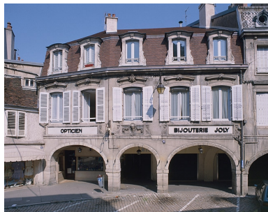
Façade antérieure. Phot. Yves Sancey IVR43_19883900099XA
