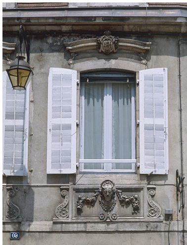
Fenêtre centrale de la façade antérieure. Phot. Yves Sancey IVR43_19883900097XA
