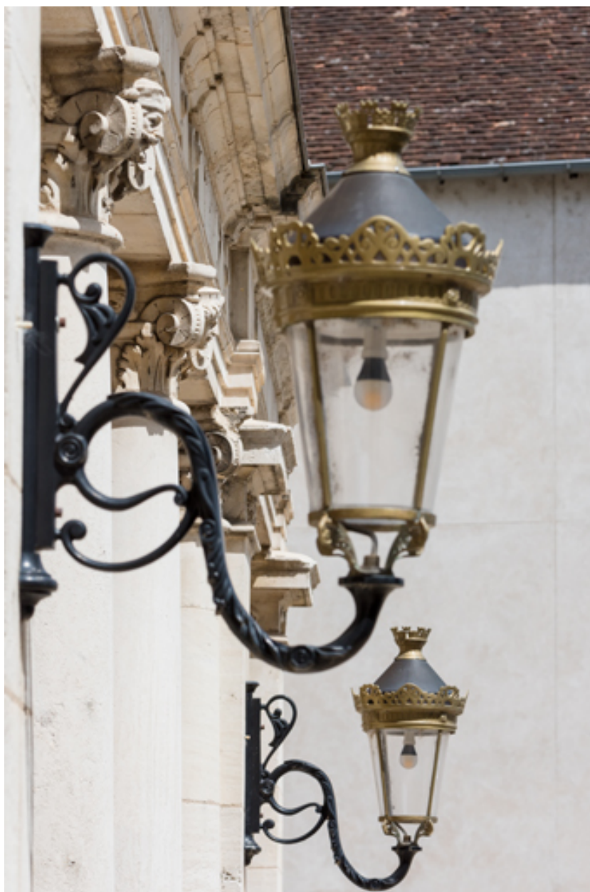
Porche : luminaires d'applique extérieurs.
