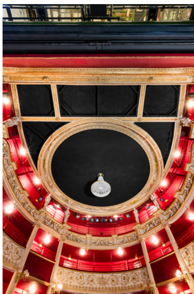
Salle : plafond (état 2024). Phot. Pierre-Marie Barbe-Richaud
