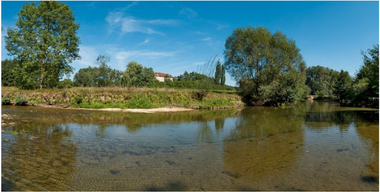
Prise d'eau dans l'Armançon.
