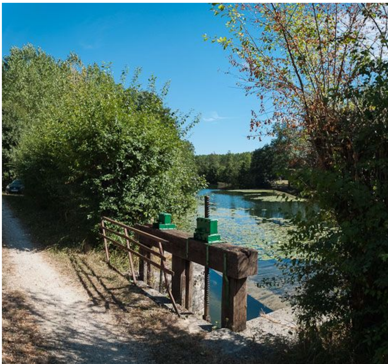
Détail des vannes.
