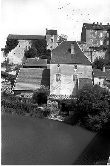
Façades donnant sur l'Ognon.
