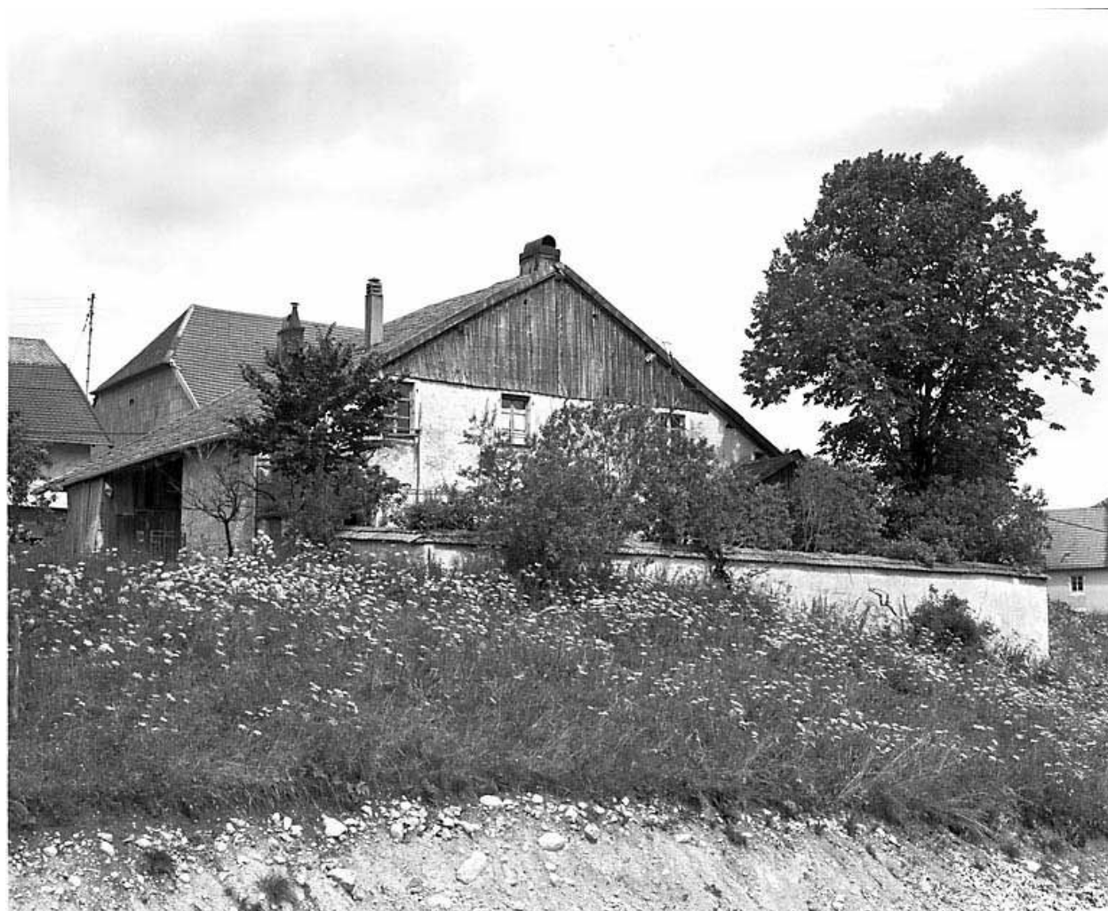
Ferme à Brey-et-Maison-du-Bois.
