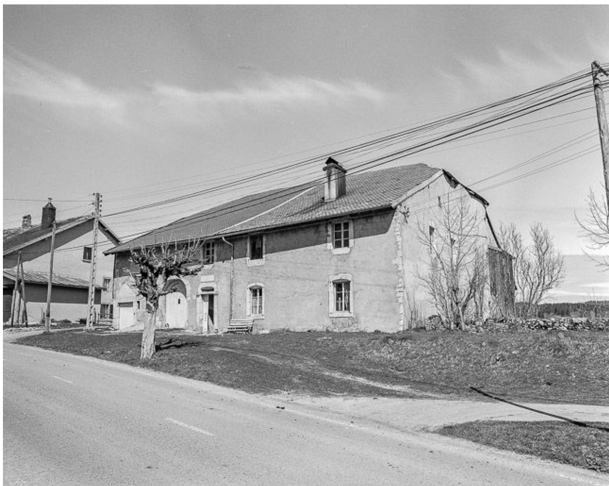
Ferme à Châtelblanc.
