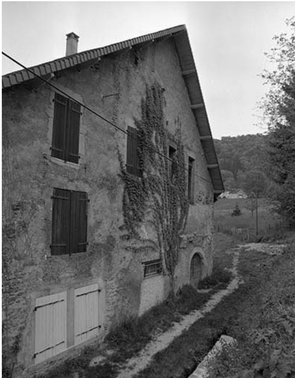
Façade latérale droite.
