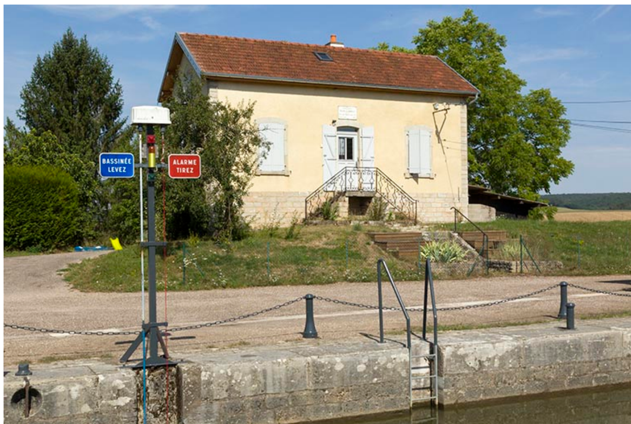
Vue de face de la maison d'éclusier.
