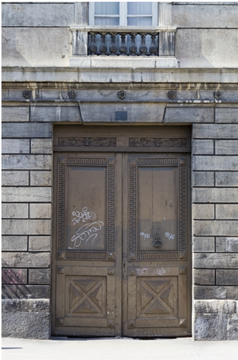
Façade antérieure : détail du portail d'entrée.
