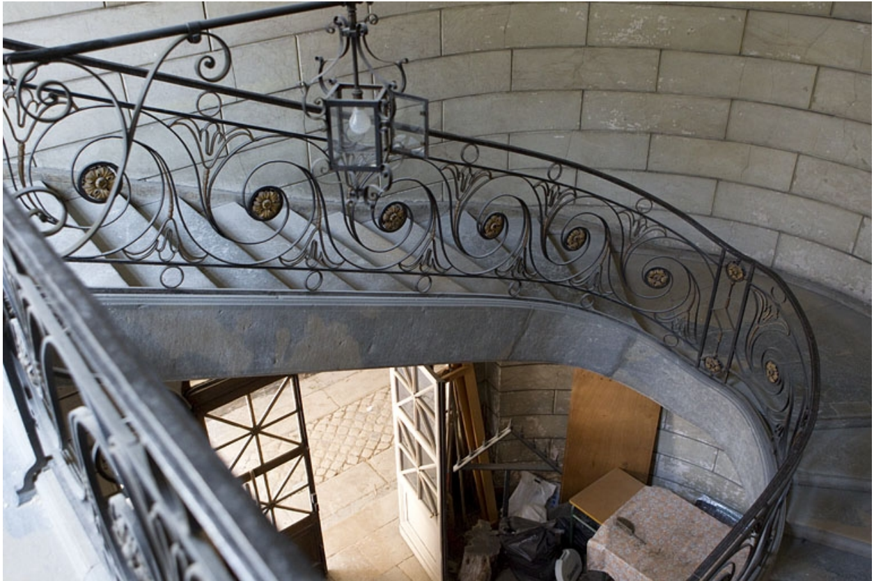
Intérieur : vue d'ensemble de l'escalier.
