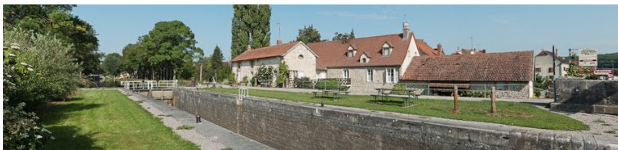
Vue d'ensemble du site d'écluse.
