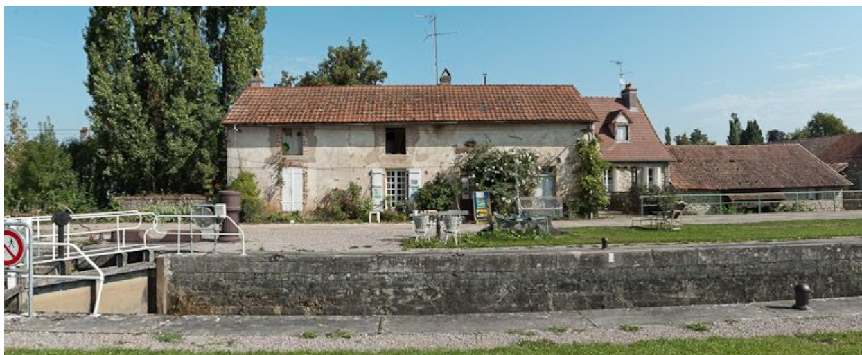
Vue de face de la maison éclusière.
