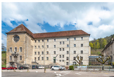
Vue depuis l'ouest. Phot. Jérôme Mongreville IVR43_20233900211NUC4A
