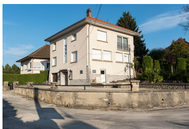
Vue d'ensemble (façades antérieure et latérale droite). Phot. Sonia Dourlot IVR43_20162501281NUC4A
