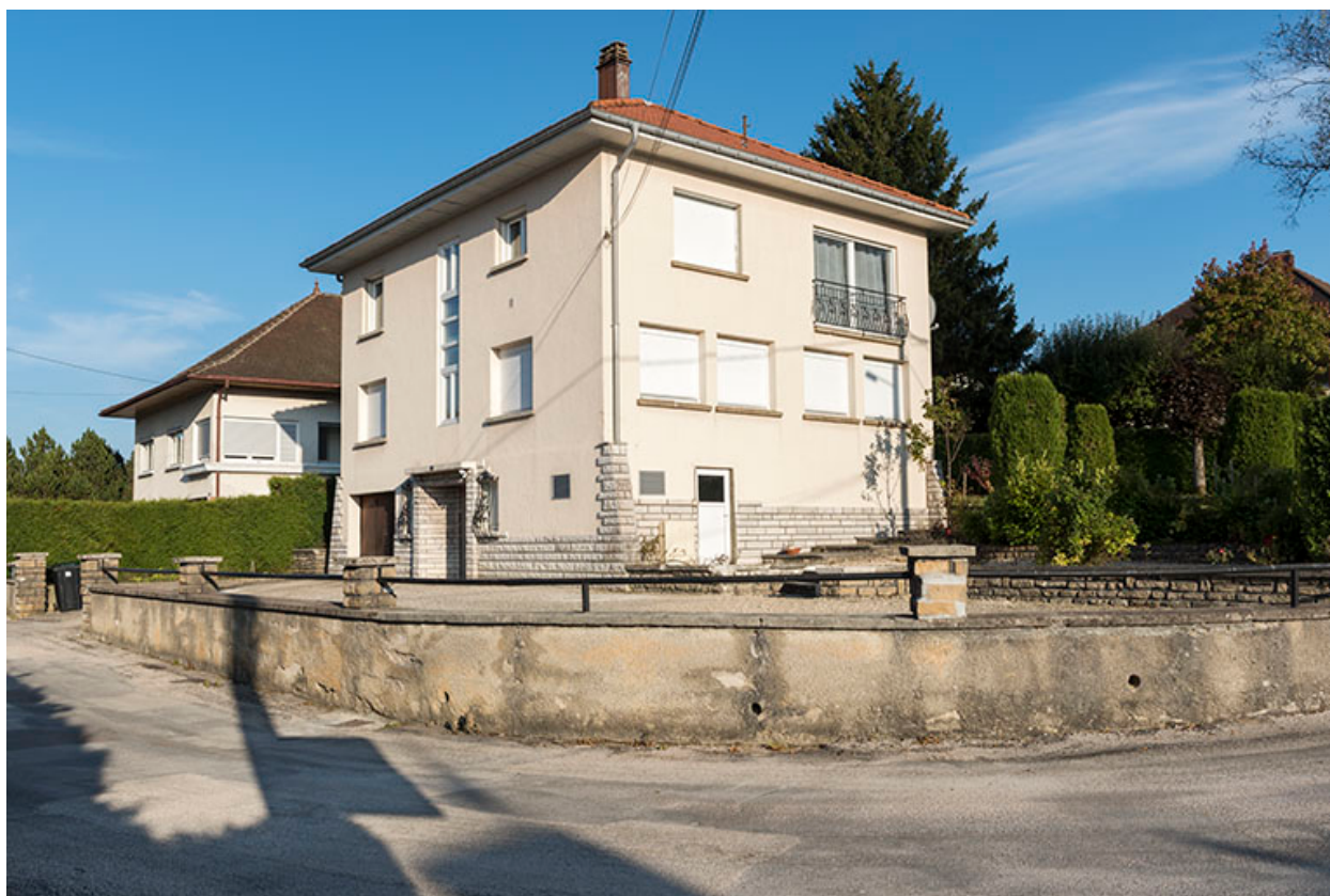
Vue d'ensemble (façades antérieure et latérale droite).
