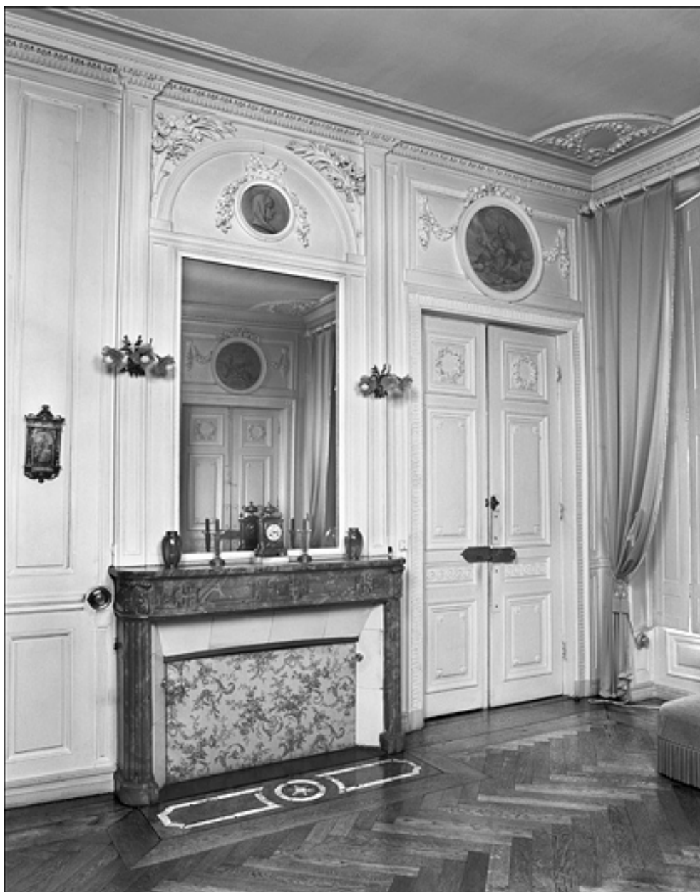
Chambre : détail de la cheminée.
