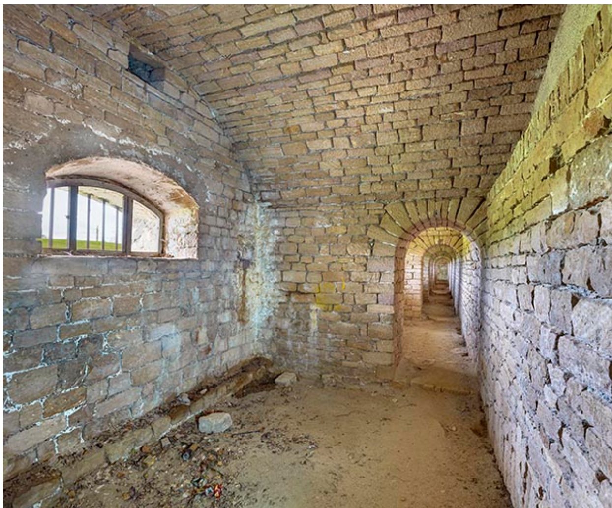
Galerie intérieure de la courtine.
