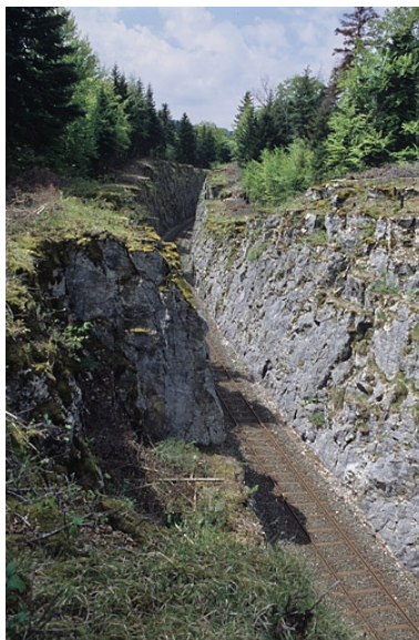
Tranchée côté Andelot-en-Montagne, vue du pont.
