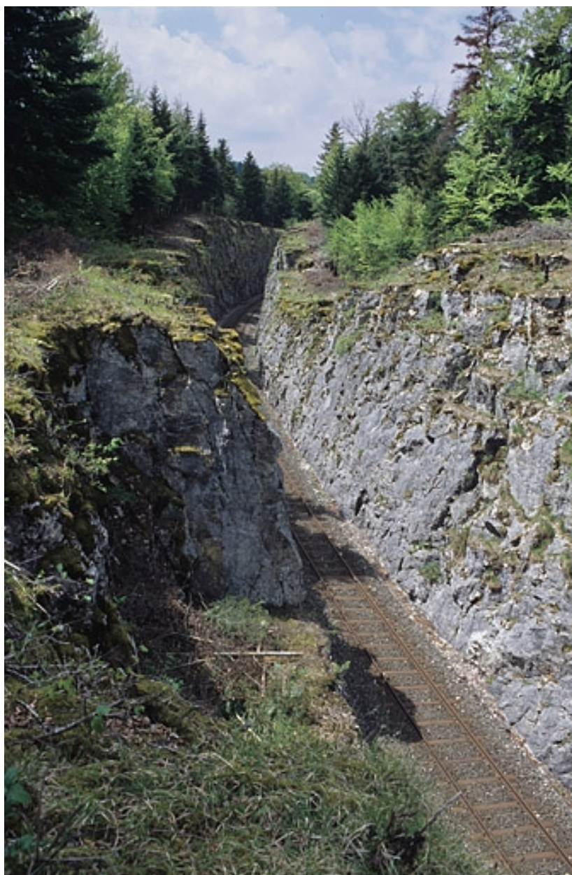
Tranchée côté Andelot-en-Montagne, vue du pont.
