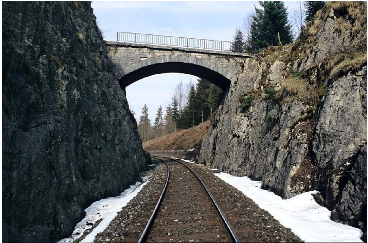
Vue d'ensemble, depuis la voie (côté Andelot-en-Montagne).
