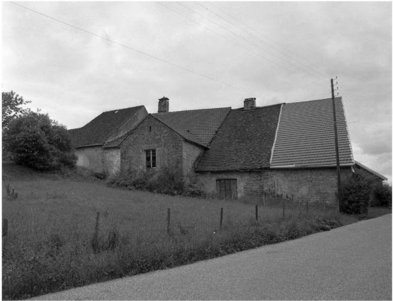
Façade postérieure avec les deux fermes voisines
