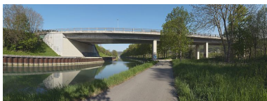
Pont vu d'aval. Phot. Thierry Kuntz IVR26_20112102600NUC4A
