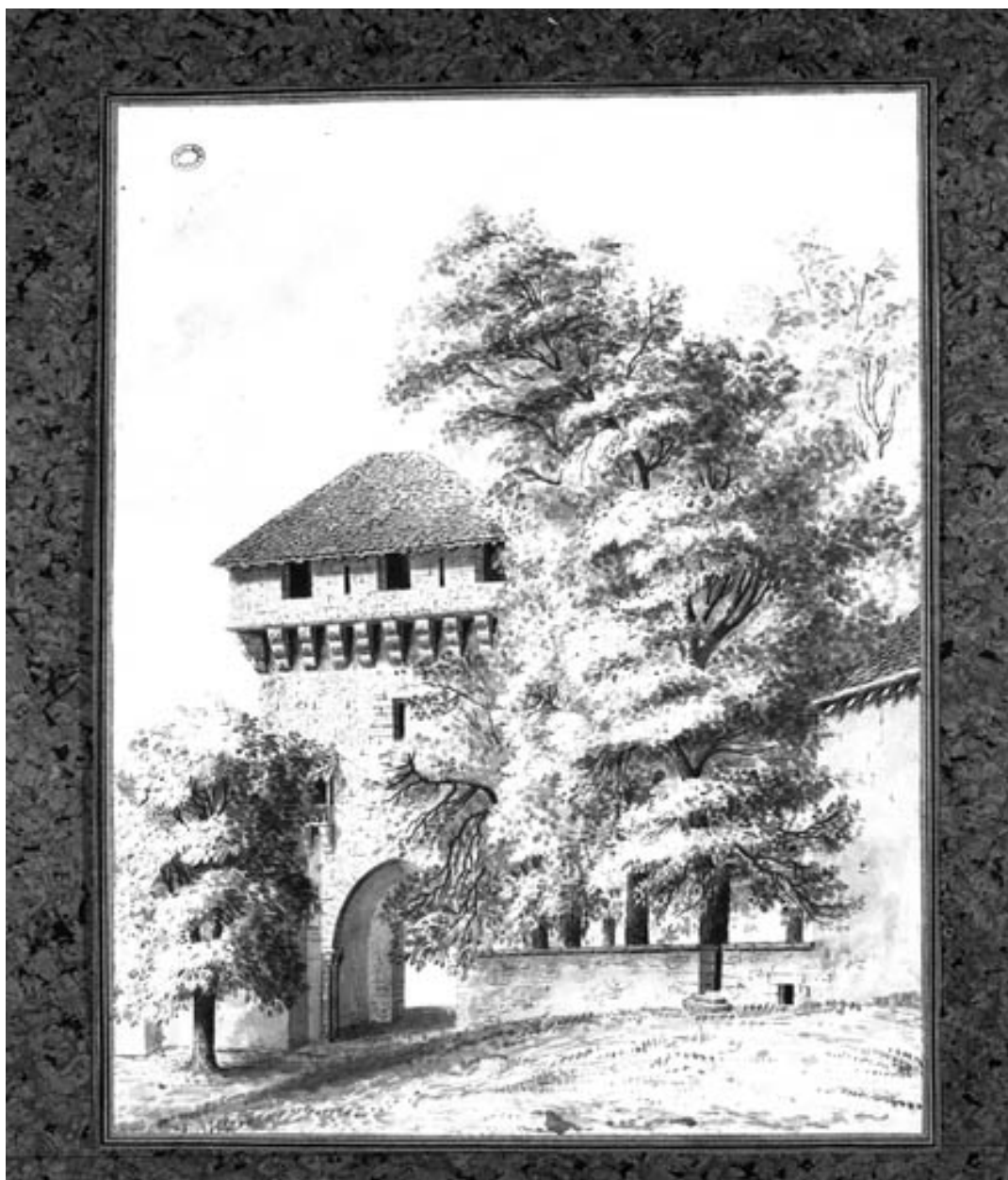
Vue de la tour du Paravis.
