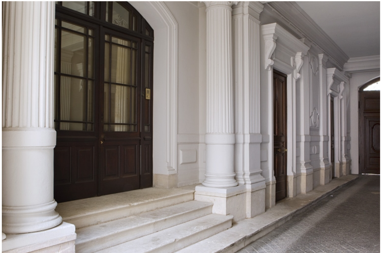
Passage cocher :détail du mur droit.
