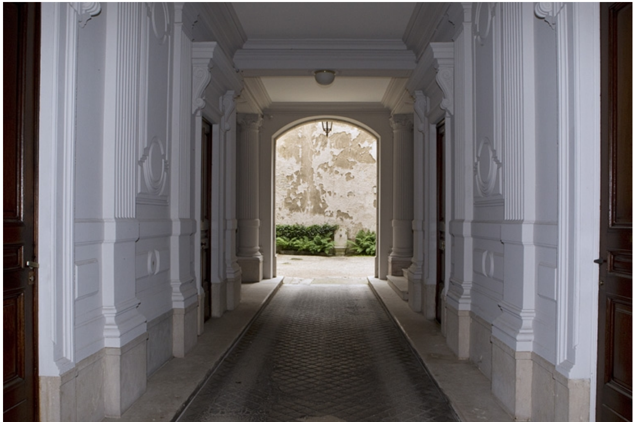
Passage cocher :vue d'ensemble depuis la cour.
