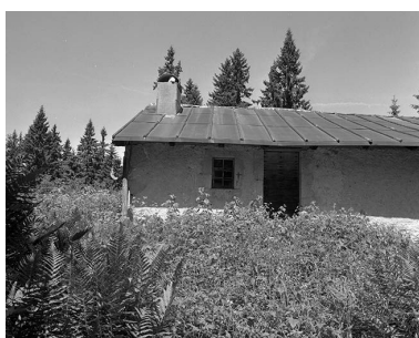
Porte d'accès de la façade antérieure. Phot. Jérôme Mongreville IVR43_20003900266X
