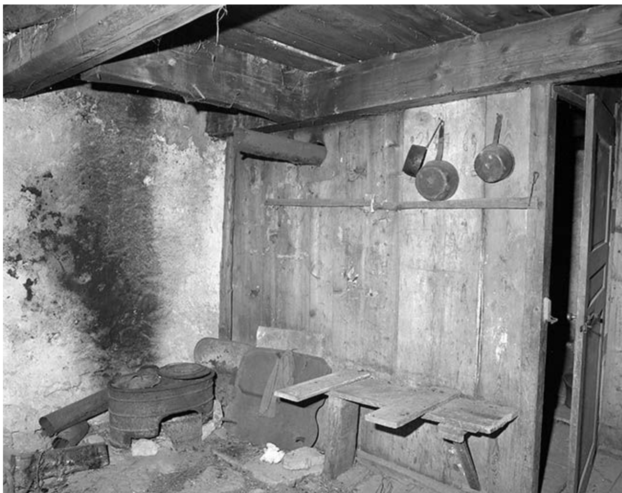
La cuisine : emplacement de la cuisinière.
