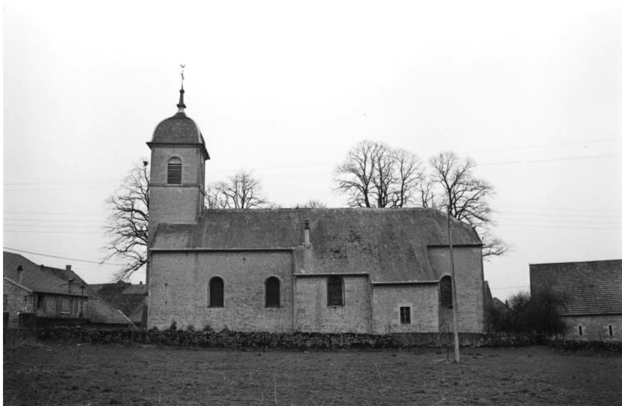
Façade latérale droite.
