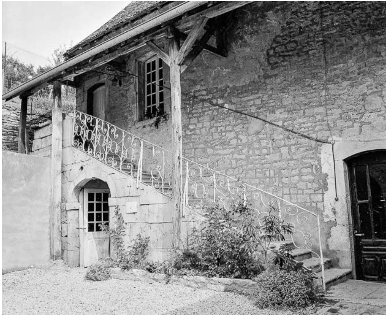
Bucey-lès-Gy, ferme (cad. G1 237) : détail de l'escalier extérieur avec entrée du cellier sous l'escalier.
