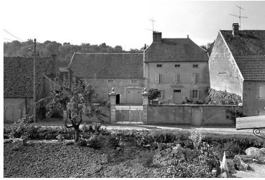
Bucey-lès-Gy : ferme (cad. G1 186) à cour fermée avec porte cochère et porte piétonne Phot. Dominique Dominguez IVR43_19807000476X
