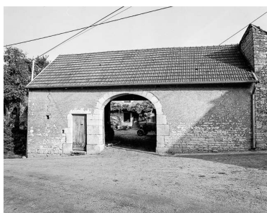
Vantoux-et-Longeville : ferme, bâtiment d'entrée sur cour. Phot. Dominique Dominguez IVR43_19807000356X
