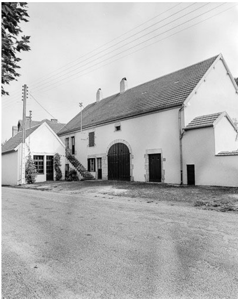
Choye : ferme avec escalier extérieur conduisant à une habitation au 1er étage, sans cellier au rez-de-chaussée.
