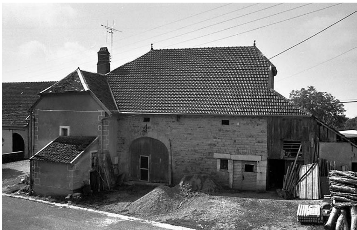
Etrelles-et-la-Montbleuse (Etrelles) : grange et écurie d'une ferme.
