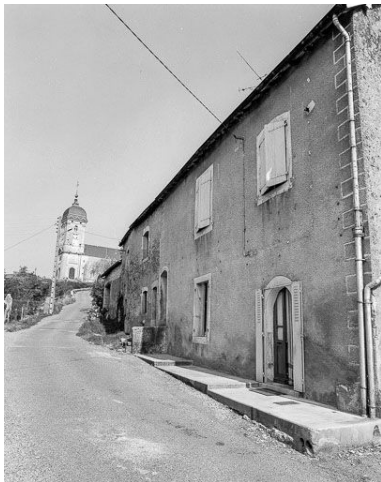
Bucey-lès-Gy : maisons situées rue du Momiron. Phot. Dominique Dominguez IVR43_19807000448X
