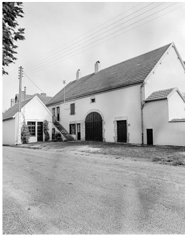
Choye : ferme avec escalier extérieur consuisant à une habitation au 1er étage, sans cellier au rez-de-chaussée. Phot. Dominique Dominguez IVR43_19807000192X
