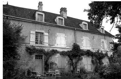
Choye : maison située 10 rue du Châtelet. Phot. Dominique Dominguez IVR43_19807000178X
