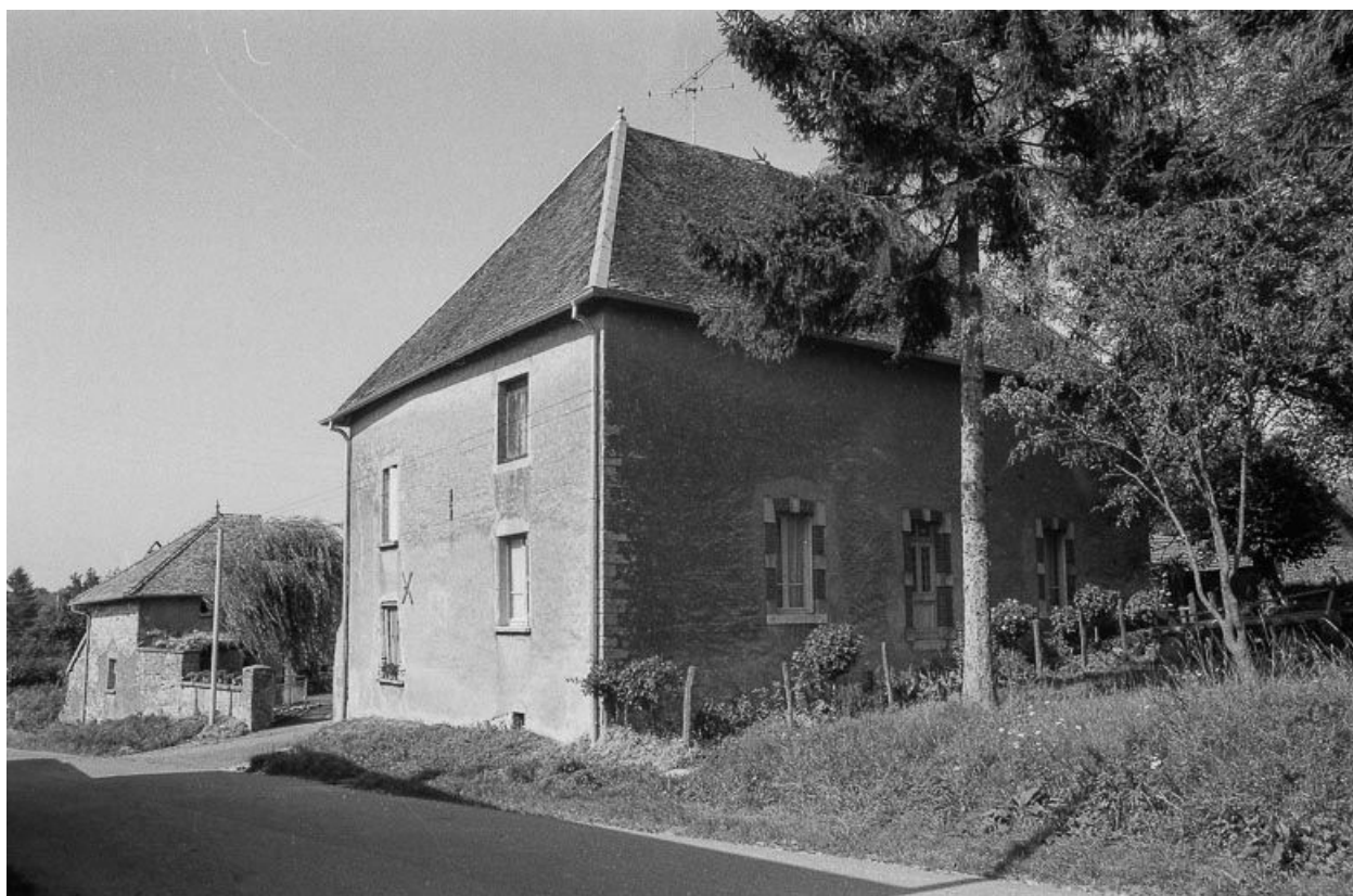
Villers-Chemin-et-Mont-lès-Etrelles : maison située à Mont-lès-Etrelles.
