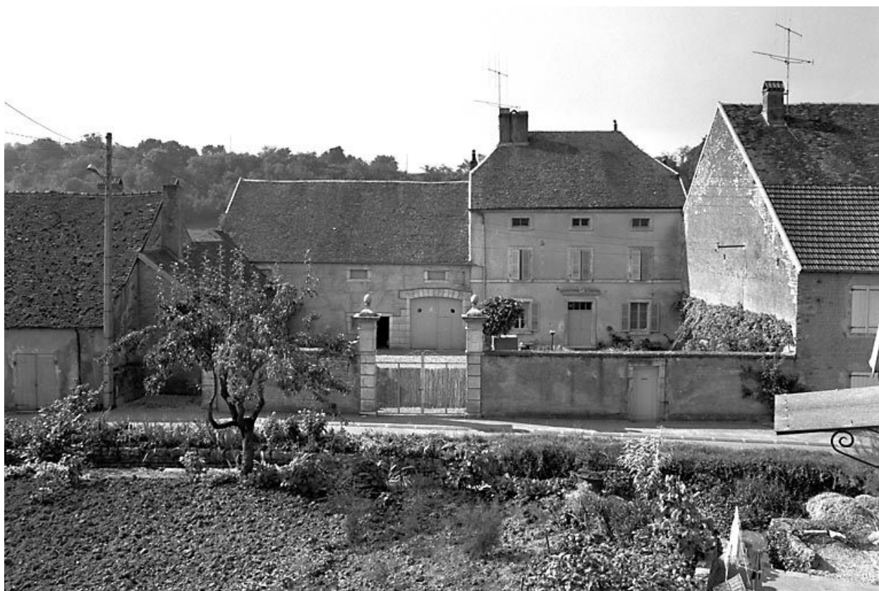
Bucey-lès-Gy : ferme (cad. G1 186) à cour fermée avec porte cochère et porte piétonne
