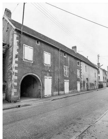
Oiselay-et-Grachaux (Oiselay) : bâtiments sur rue avec habitation sur porche vus de trois quarts gauche. Phot. Dominique Dominguez IVR43_19807000331X
