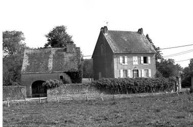
Frasne-le-Château : maison située chemin rural dit du Paquit. Phot. Dominique Dominguez IVR43_19807000256X
