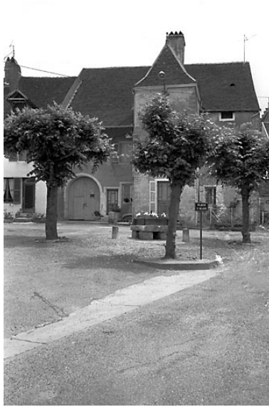
Façade antérieure vue depuis la place. Phot. Bernard Lardière IVR43_19817000798Z
