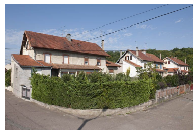
Habitations à 4 logements vues depuis l'est. Phot. Jérôme Mongreville IVR43_20112502028NUC4A
