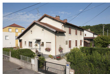
Habitation à 2-3 logements vue de trois quarts. Phot. Jérôme Mongreville IVR43_20112502027NUC4A
