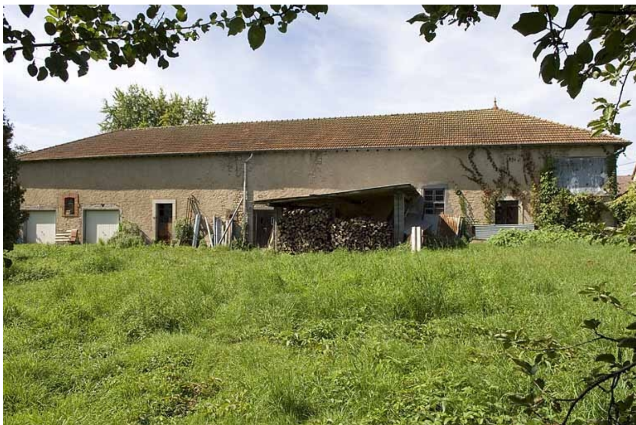
Atelier de distillation. Façade sur le jardin.
