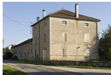
Logement et atelier depuis la route départementale. Phot. Jérôme Mongreville IVR43_20067000821NUCA
