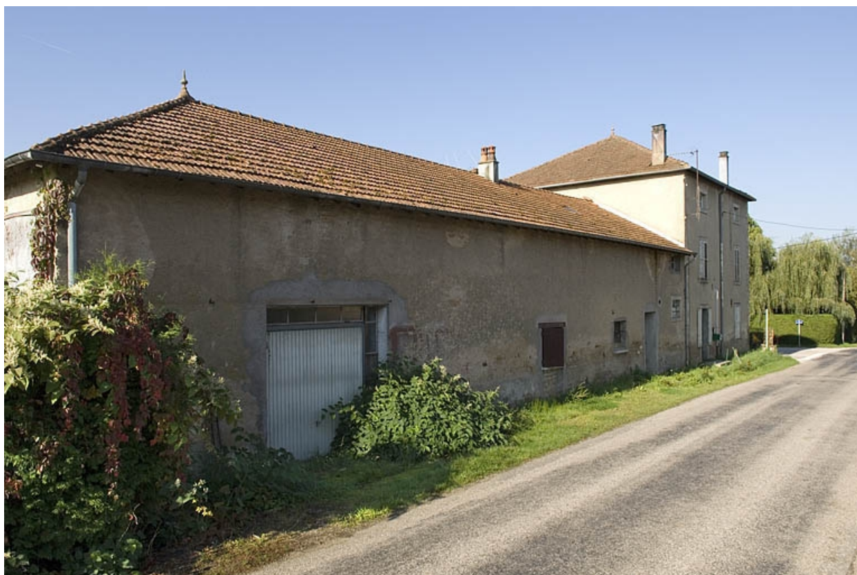
Atelier et logement depuis l'est.
