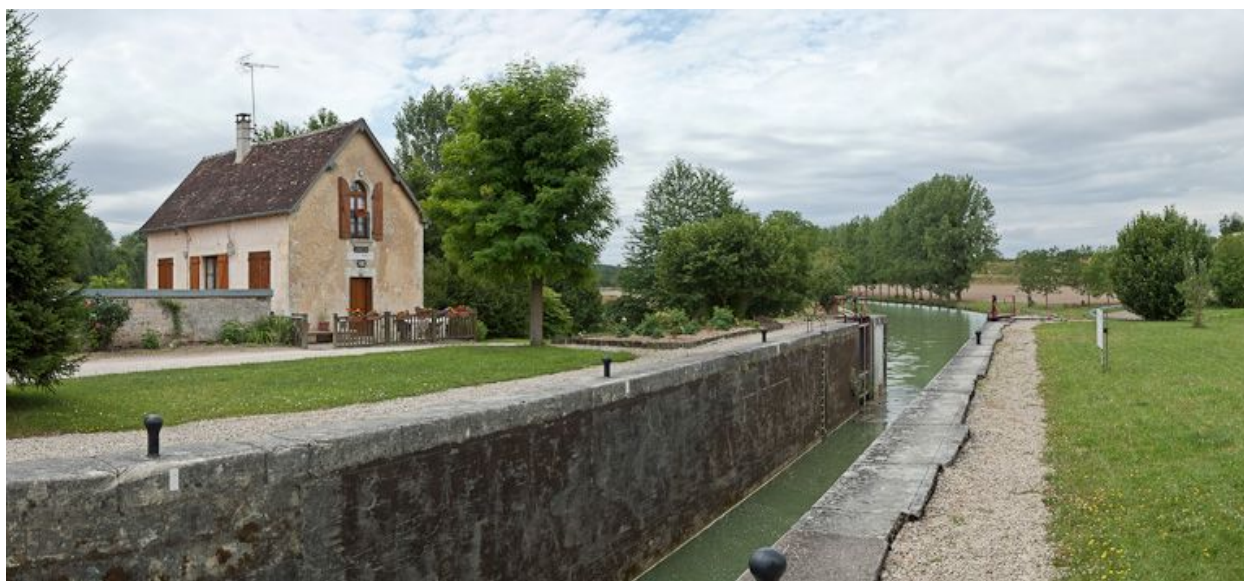
Vue d'ensemble du site d'écluse.
