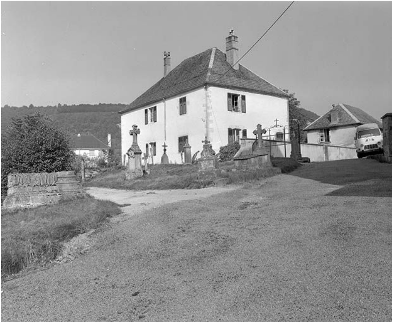
Façade postérieure et face latérale gauche.
