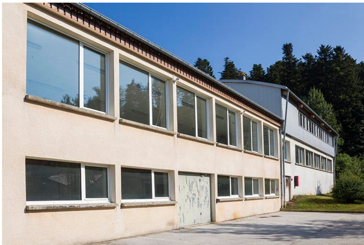
Façade latérale gauche, vue en enfilade.
